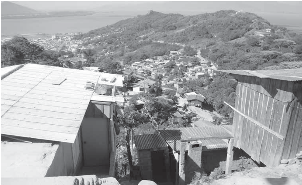
Figura 14 – Detalhe da precariedade da edificação em áreas declivosas suscetíveis à erosão. Foto do alto da Caieira do Saco dos Limões feita por Mario Beerli em 2008.
